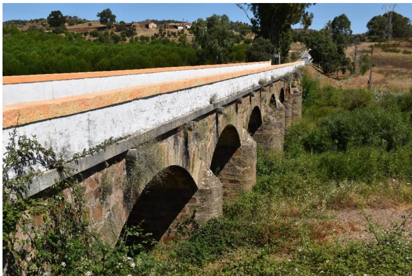
Fig. 11 – A ponte do Vascão, na Estrada Nacional 2
